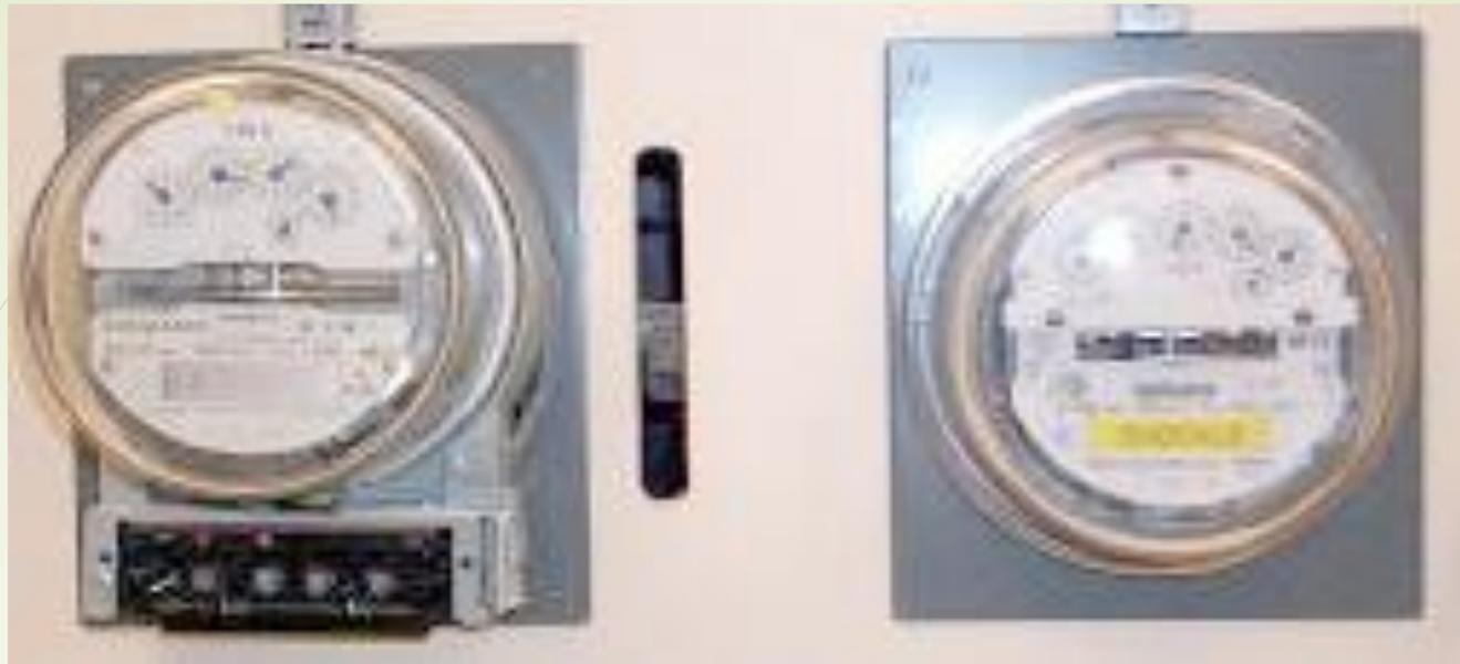
**Medidor básico de inducción o medidor electromecánico**
