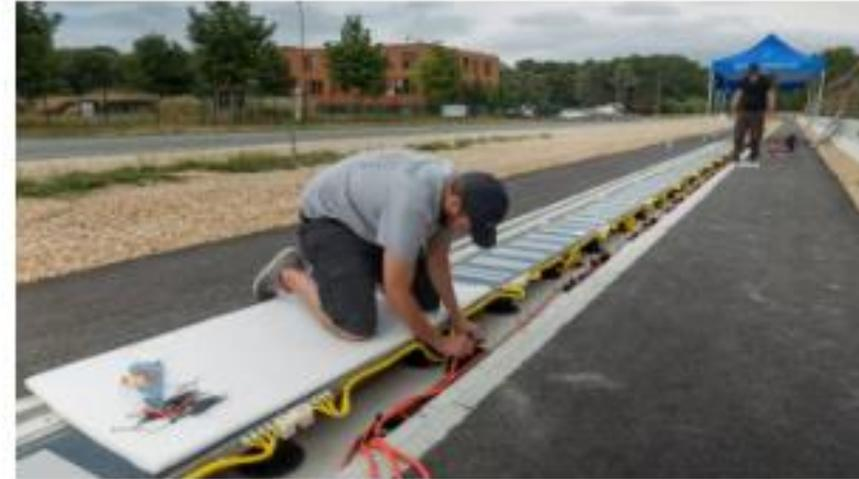
Instalación del sistema de carga dinámica por inducción para coches eléctricos. QUALCOMM
